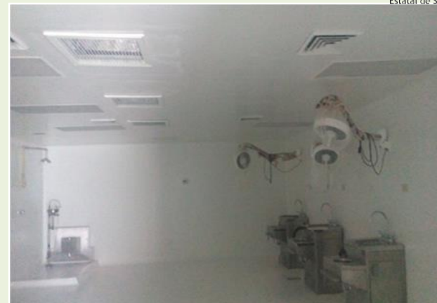
AMPLIACIÓN Y MEJORAMIENTO DE LA TERMINACIÓN DEL EDIFICIO DEL SEMEFO DE LOS MOCHIS, SINALOA
